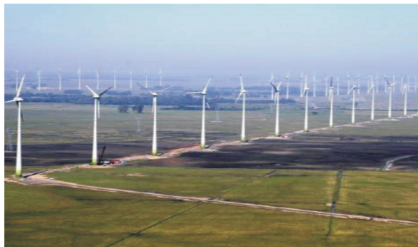
Osório – 50 MW (Osório, RS)
