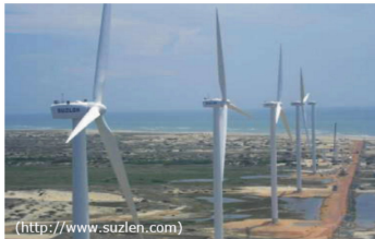
Paracuru – 23,5 MW (Paracuru, CE)
